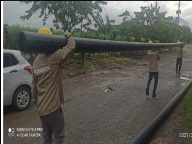
Proceso De Colocacion De Laa Tuberia De Polietileno Para Su Instalacion.
