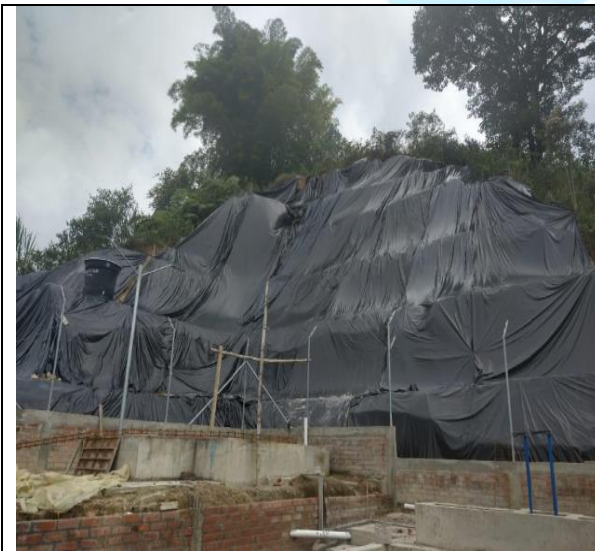
Panorámica PTAP –Vereda Alaska
